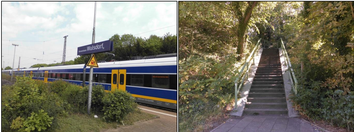
Fotos: Der Bahnhof Wulsdorf (linkes Bild) wird zukünftig auch barrierefrei zu erreichen sein. Aktuell erfolgt der Zugang z. B. über die Treppe im rechten Bild.
