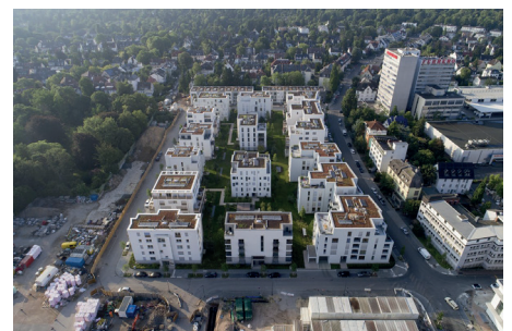
Referenzprojekt: Frankfurt - Quartier am Henninger Turm, HochtemperaturWärmenetz und Niedertemperatur-Wärmenetz zur Nutzung als Kältenetz im Sommer in Verbindung mit einer Geothermieanlage. Fotos (2): Felix Krumbholz
