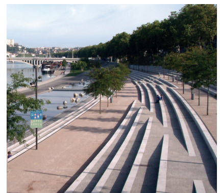
Projektbeispiel: Rampe in Treppe integriert - Berges-du-Rhone https://da.wikipedia.org/wiki/Fil:Berges_du_Rh%C3%B4ne.JPG
