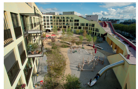
Projektbeispiel: Gemeinsame Raumnutzung - Kalkbreite Zürich Foto: VolkerSchopp https://www.kalkbreite.net/kalkbreite/gemeinsam-nutzen
