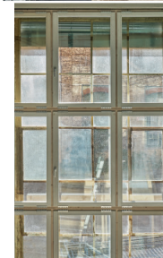
Projektbeispiel: Zirkuläres Bauen - K 118 Winterthur, Schweiz 2021 - baubüro in situ / zirkulär https://www.insitu.ch/projekte/196-k118-kopfbau-halle-118
